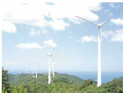
図1 陸上風力発電所の例
