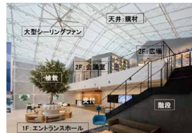
写真2 建物の内観(膜構造建築物)
