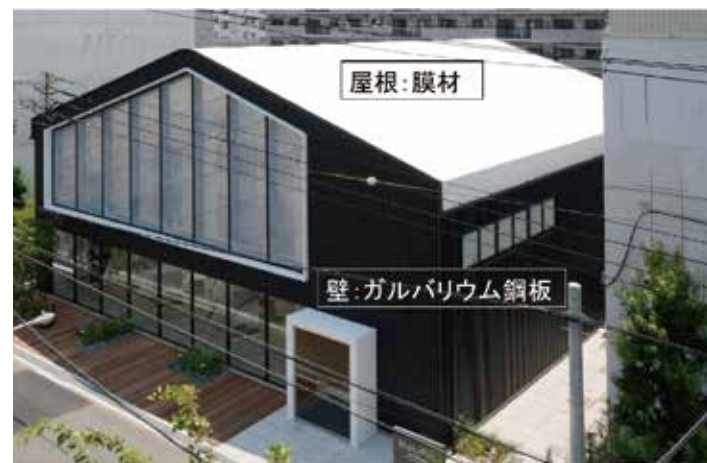
写真1 建物の外観と構成部材
