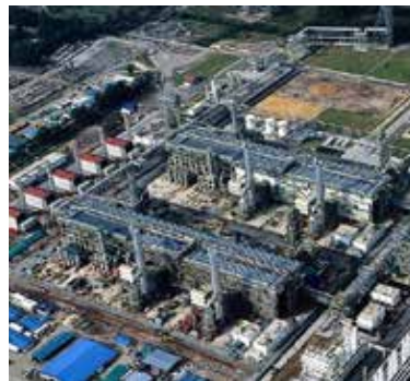
写真1 LNGプラント(1)
