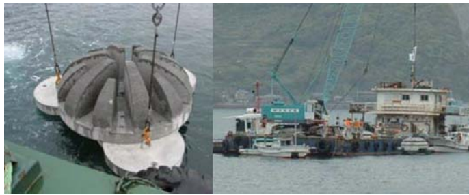
写真1. コンクリート製漁礁のフィールドテスト設置工事の様子
