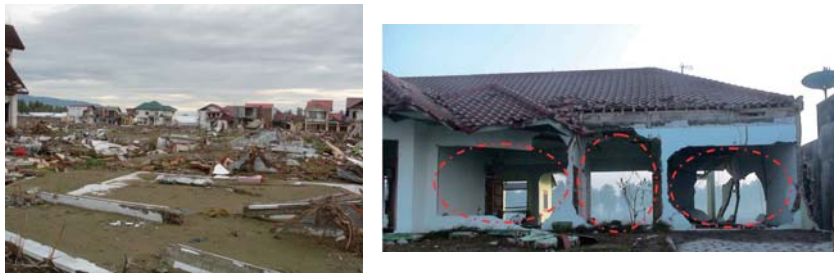
写真1. 地震津波による被害状況 (左: 2004年スマトラ沖地震、右: 2006年ジャバ沖地震)
