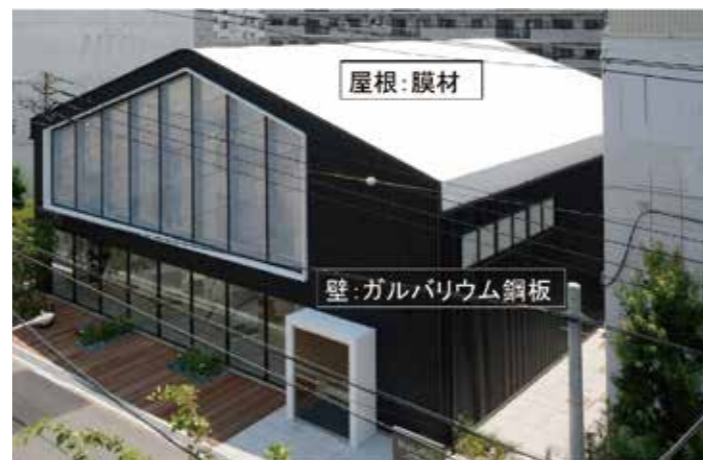
写真1 建物の外観と構成部材
