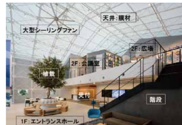
写真2 建物の内観(膜構造建築物)
