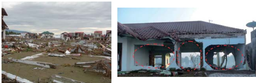
写真1. 地震津波による被害状況 (左: 2004年スマトラ沖地震、右: 2006年ジャワ沖地震)
